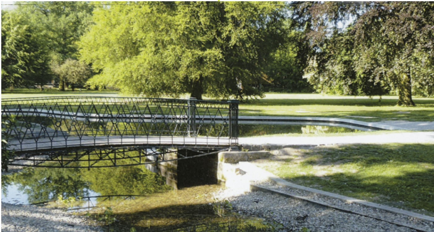
Der Teich im Welfengarten hinter dem Hauptgebäude wurde anlässlich des 200. Geburtstages von Georg Ludwig Friedrich Laves 1988 neu angelegt. Zur Teichanlage gehört auch die ursprünglich von Hofbaumeister Laves entworfenen Brücke. 2012 wurde die Teichanlage komplett saniert.
