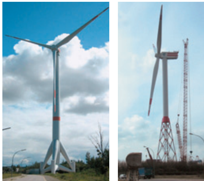
Bild 3 Links: Multibrud M5000, Tripod (Bremerhaven); rechts: REpower 5M, Jacket (Bremerhaven) Quelle: Institut für Statik und Dynamik, Leibniz Universität Hannover
