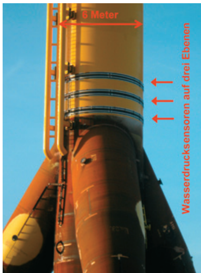
Bild 5 Tripod (Multibrid) mit Messsystem Quelle: DEWI (2008)
