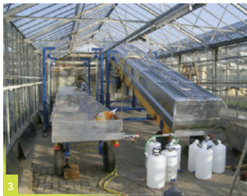
Abbildung 2 Einbau einer Dachbegrünung zur Ermittlung des Abflussverhaltens Foto: Gilbert Lösken
