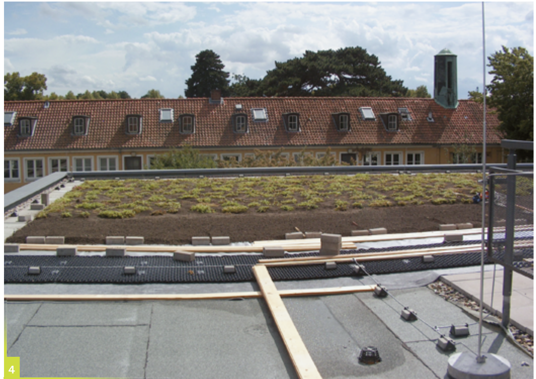
Abbildung 4 Herstellung einer Versuchsfläche zur langfristigen Messung des Abflussverhaltens auf dem Dach des Instituts für Bodenkunde in Herrenhausen. Foto: Gilbert Lösken
