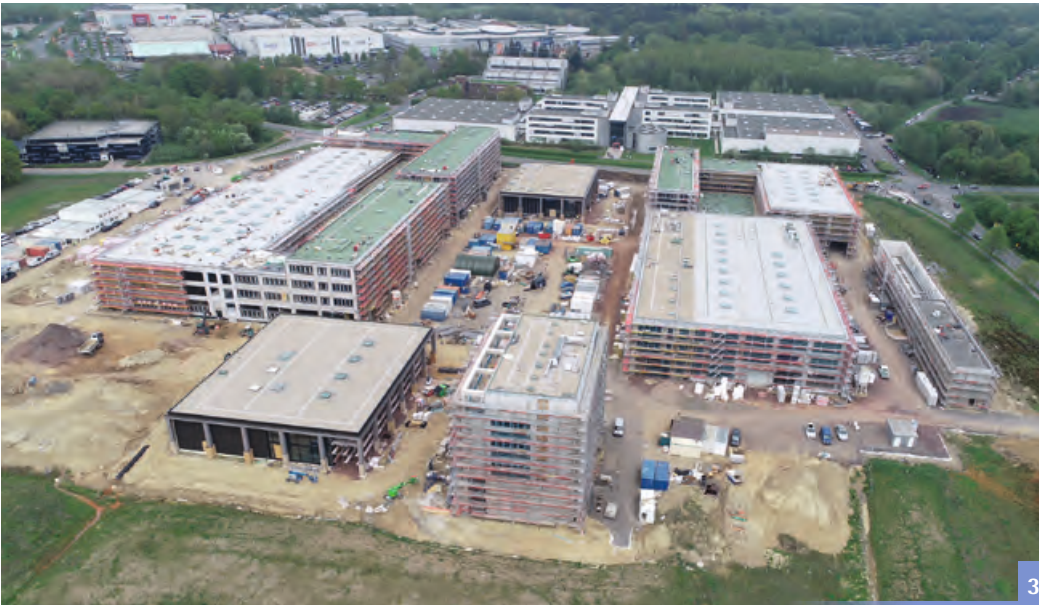
Abbildung 3 Abschluss der Fassaden- und Dacharbeiten – Frühsommer 2018 – Blick von Westen auf das Baugebiet. Ganz hinten ist der markante Eingang des PZH zu sehen.
