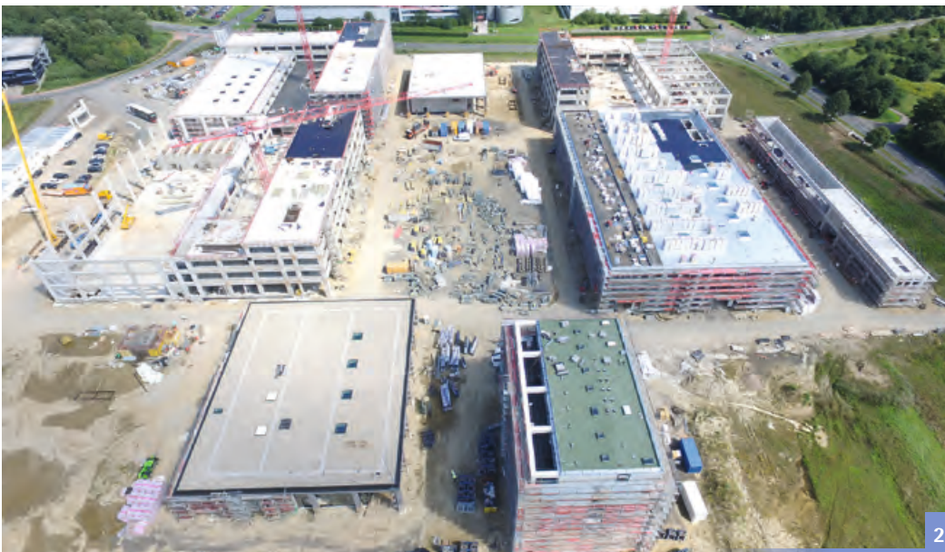
Abbildung 1 Erdbauarbeiten – Einbau von Rüttelstopfsäulen – Sommer 2016 – Blick von Norden auf das Baugebiet.
