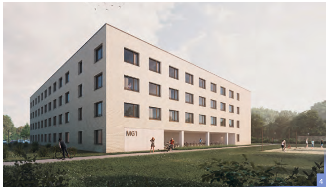
Abbildung 4 Außenansicht des Studentenwohnheims Foto: (c) Römeth BDA . Wagener Architekten
