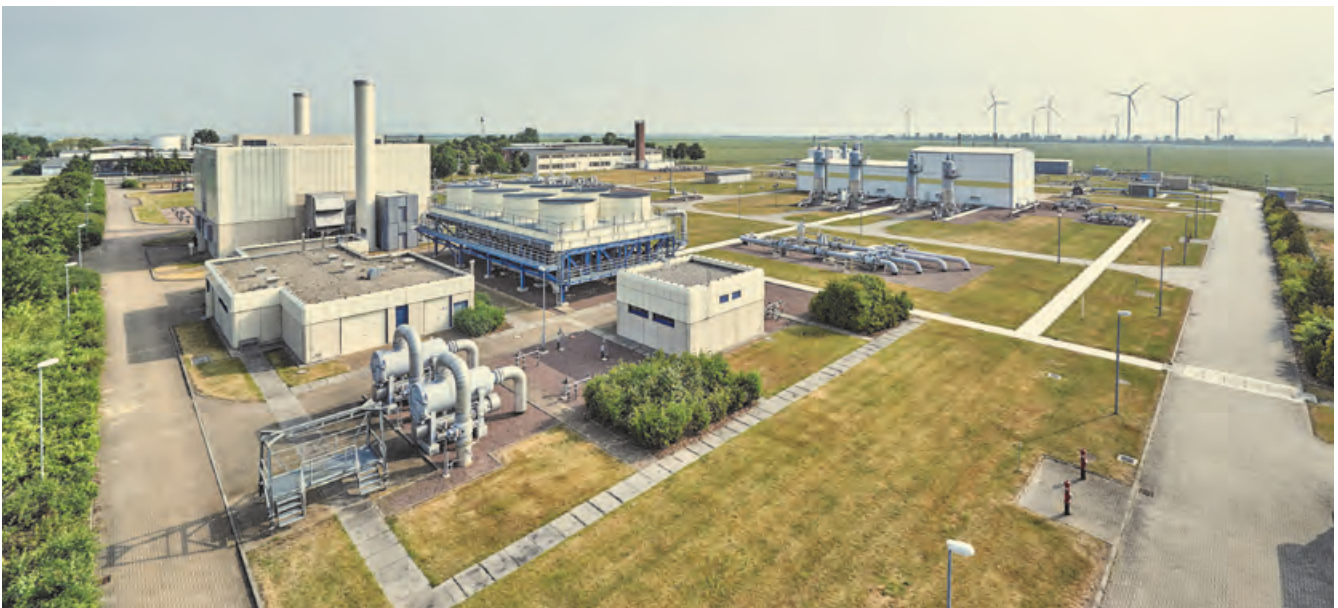
Der weltweit erste Kavernenspeicher für grünen Wasserstoff wird als Forschungsbetrieb der VNG Gasspeicher GmbH in Lauchstädt entstehen. Die Wasserstoffkaverne liegt in 895 bis 1.080 Metern Tiefe. Quelle: VNG Gasspeicher GmbH
