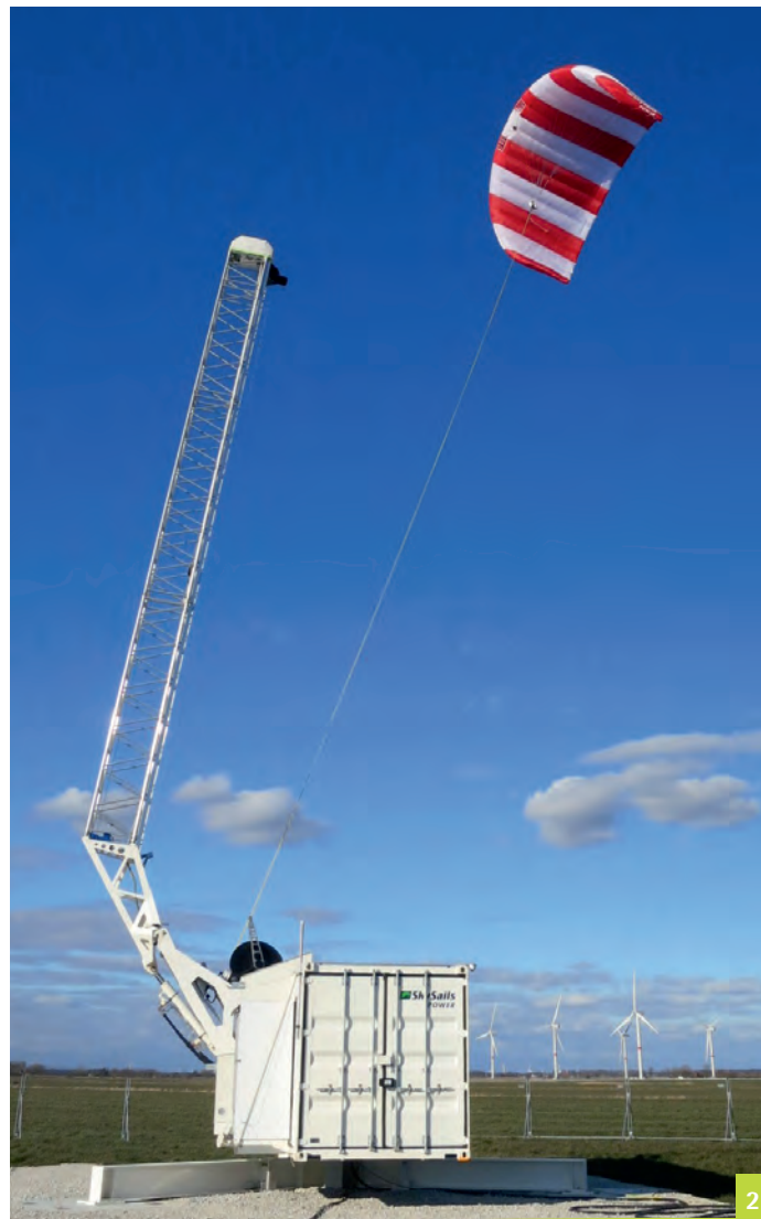
Abbildung 2 Im Probebetrieb: Die erste Höhenwindenergieanlage Deutschlands bei Klixbüll in Schleswig-Holstein. Foto: Skysails
