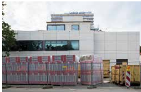
Rendering und Baustelle Hannover Institut für Technologie
