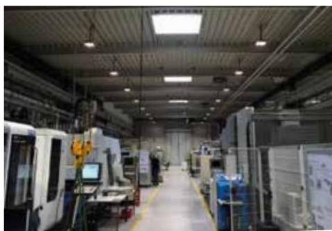
LED Beleuchtung im PZH
