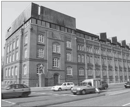
Im Spätsommer ziehen die Institute in die Schloßwender Straße.
