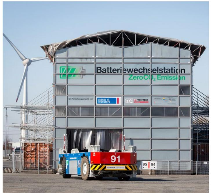
In der Batterieladestation können die Batteriesysteme der Containertransporter vollautomatisiert gewechselt werden.
