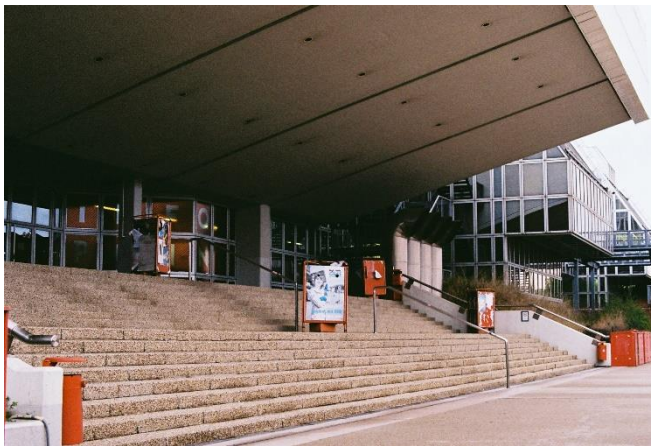
Alte WU, Gebäude der Raumplanung in Spittelau
