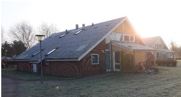
Haushälfte im Hedelundvej
