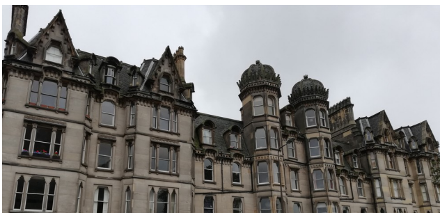
Hausfassaden in Marchmont
