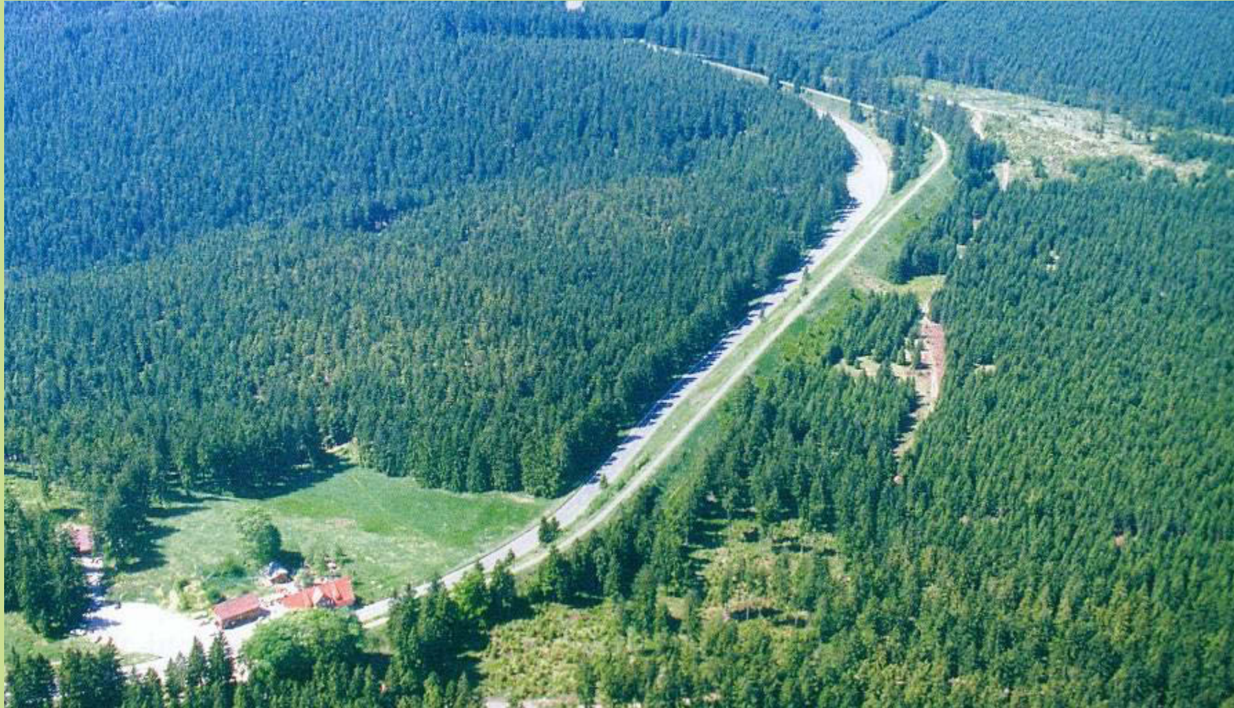
Der Sperberhaier Damm, erbaut 1732 bis 1734 16 m hoch und 953 m lang
