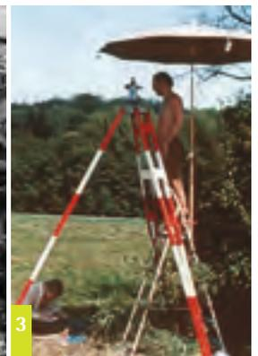
**Bild 1:** Exkursion des 6. und 8. Semesters nach München mit Prof. Hake, 1971 • **Bild 2:** Nach bestandenenem Diplom: Rückkehr an die Vermessungsstätte in Ravensberg im Harz, 1972 • **Bild 3:** Vermessungsübung im Südharz 1970: Triangulationsmessung mit Theodolit und 3-Meter-Stativ.
