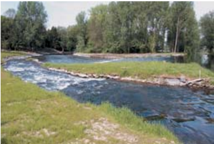
Abbildung 2 Raue Sohlengleite an der Leine in Gronau
