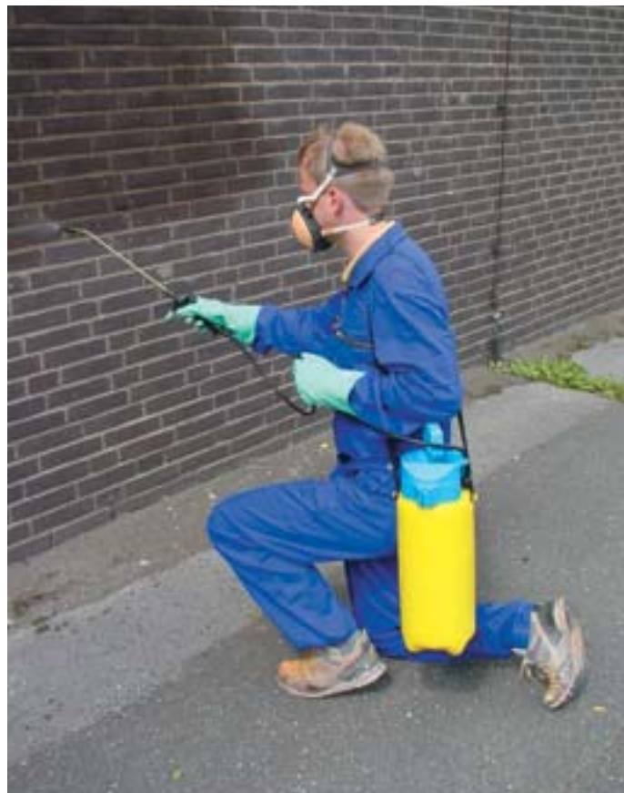
Bild 5 Applikation einer Hydrophobierung mit der Gartenspritze.
