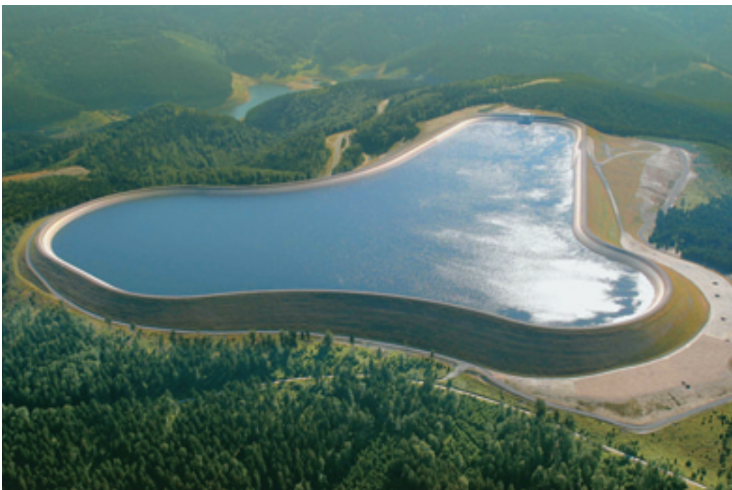
Abbildung 4 Oberbecken des Pumpspeicherwerkes Goldisthal in Thüringen mit 12 Mio m 3 Speichervolumen.
