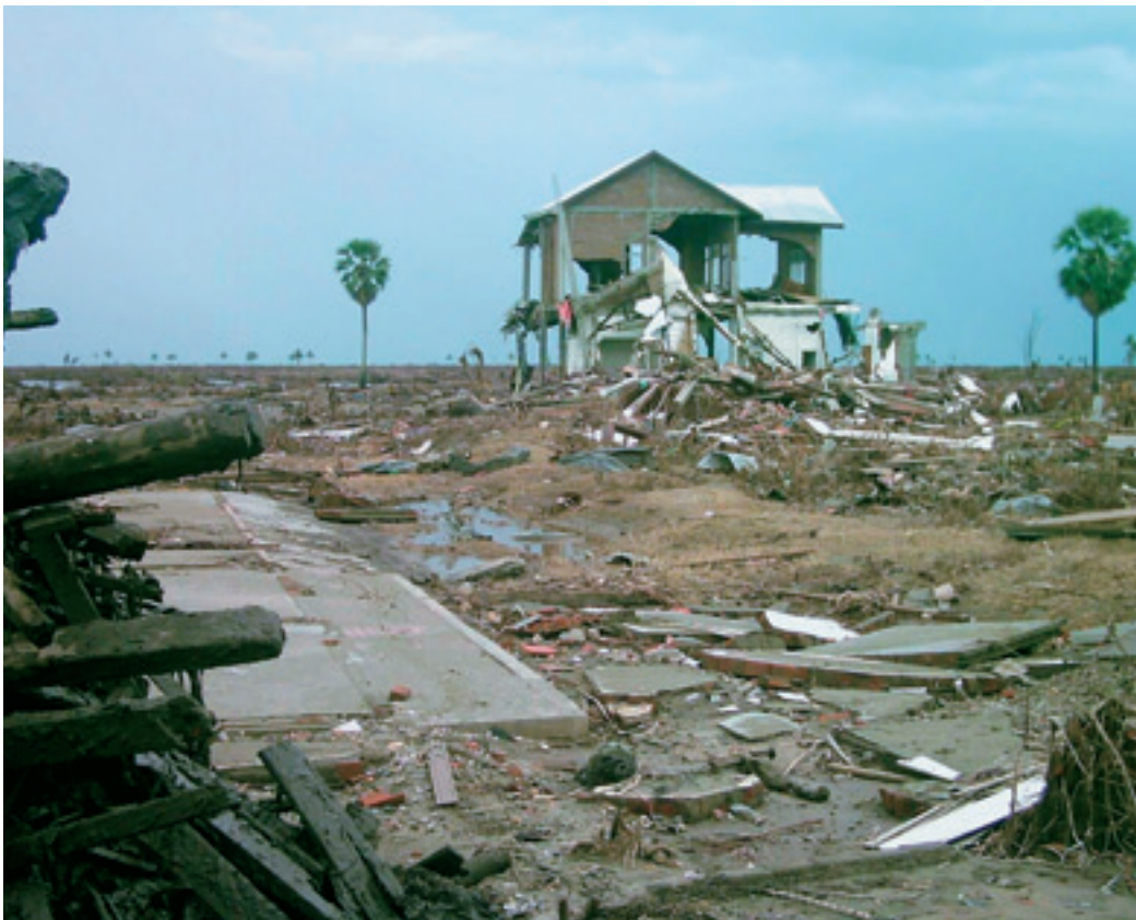
Abbildung 1 (links) Die zerstörerische Kraft des Tsunamis. Quelle: THW
