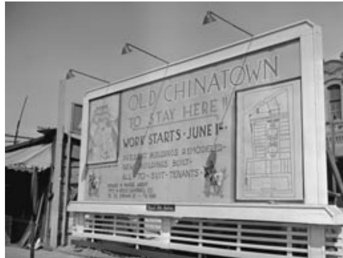
Abbildung 3 Um 1848 entstanden in der Hafenstadt San Francisco und in anderen amerikanischen Städten die ersten Chinatowns auf nord-amerikanischem Boden. Die Plakatwand kündigt die Bauarbeiten an.
