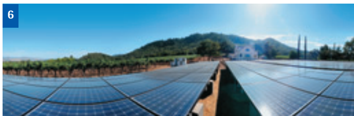
Abbildung 6 Photovoltaik-Anlage in Südeuropa. Durch den steileren Einfall des Sonnenlichts steigt die Energieausbeute gegenüber unseren Breitengraden etwa um den Faktor 2 an. Quelle: SMA
