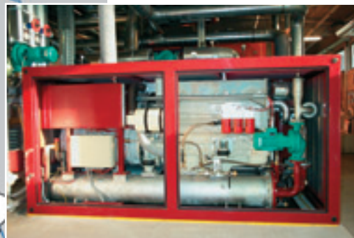
Bild 3 Blockheizkraftwerke und andere dezentrale Energieerzeugungsanlagen speisen auf Basis von fossilen und nachwachsenden Brennstoffen in MS- und NS-Netze ein. Quelle: COMUNA-metall
