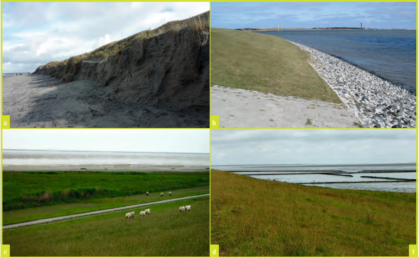
Abbildung 1 von oben links nach unten rechts: a) Dünenabbruch als Resultat von Orkan Sabine auf Norderney; b) Geschlossenes technisches Deckwerk als Deichfußsicherung auf der Wattseite von Norderney; c) Salzwiesen im Deichvorland, Leybucht; d) Lahnungen im Deichvorland zwischen Neuharlingersiel und Bensersiel alle Fotos: Maïke Paul
