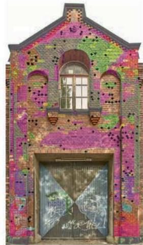
Basis für die Fassadenanierung ist der fotogrammetrische Bildplan – er kartiert die Salz- und Fugenschäden sowie Graffiti an der Fassade.
