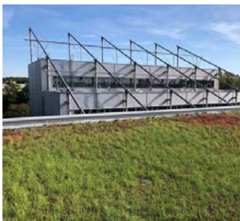
©LUH | Gründach auf dem Unterwassertechnikum in Garbsen
